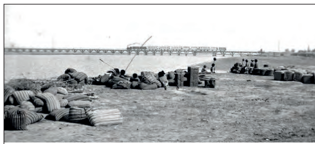
Dřevěný železniční most přes Amudarju, v popředí pytle s bavlnou.
