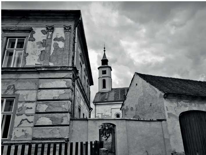
Obr. 3: Semtětšský evangelický areál, vpředu fara, v pozadí kostel, který náleží k největším v Čechách (scházelo se zde na bohoslužbách až 500 věřících). Dnes není komplex v dobrém stavu (foto archiv autora)
